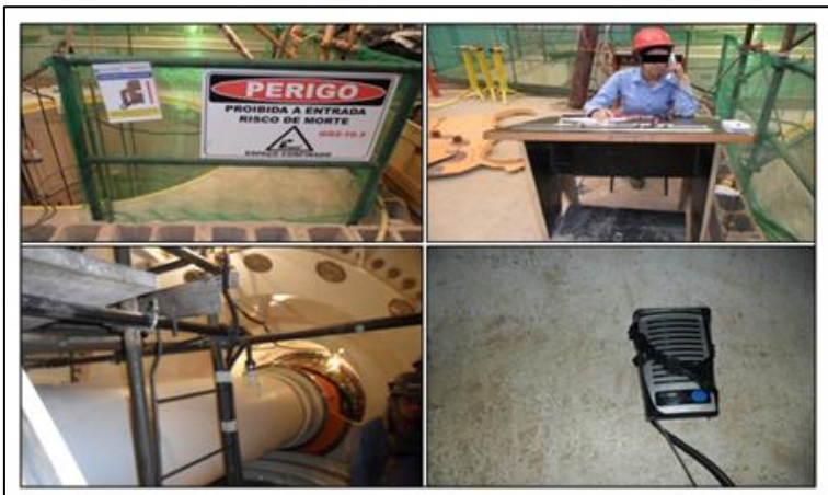
Figura 39 - Placas de sinalização, vigia e sistema de comunicação entre vigia e trabalhadores no espaço confinado 3
