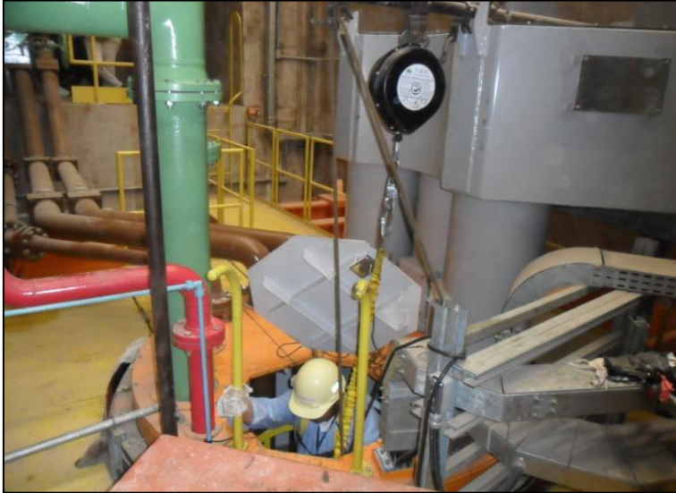
Figura 36 - Sistema de trava queda retrátil Fonte: Arquivo pessoal
