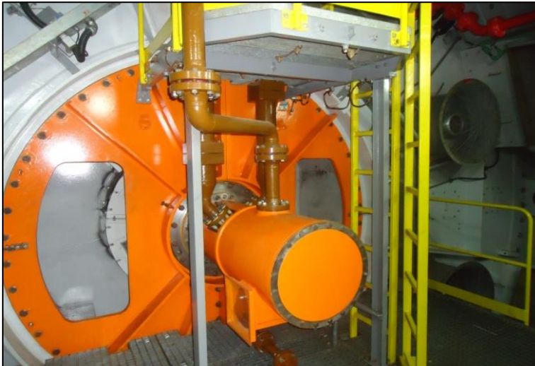
Figura 7 - Área 2 - gerador nariz do bulbo - Bulbo Nose Fonte: Arquivo pessoal
