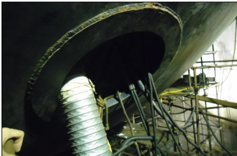
Figura 5 - Escotilha de acesso do espaço 1 para o espaço 2
