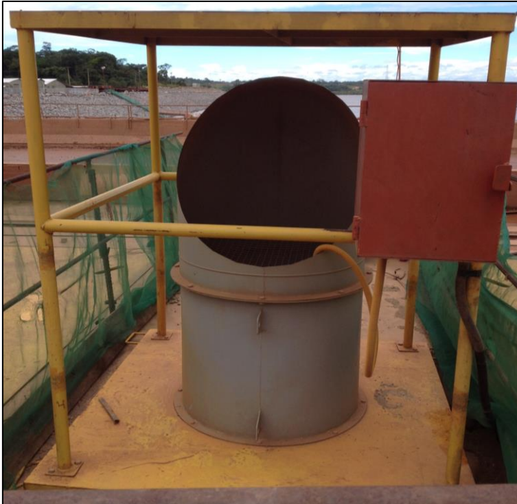
Figura 20 - Sistema de exaustão que atende espaço 1 e 4 operativo Fonte: Arquivo pessoal
