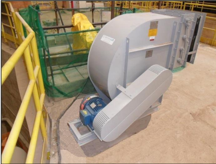
Figura 16 - Sistema de exaustão que atende espaço 2 e 3 Fonte: Arquivo pessoal
