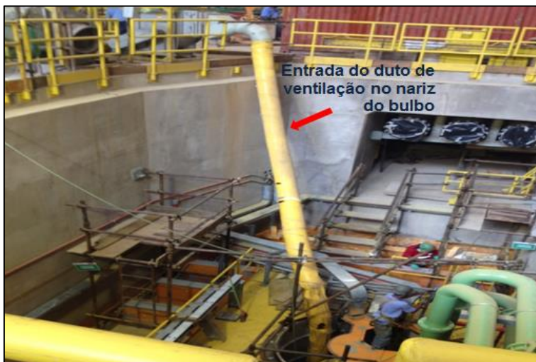
Figura 17 - Área 2 - nariz do bulbo (gerador sistema de exaustão) Fonte: Arquivo pessoal
